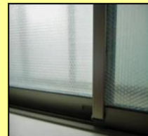
断熱シートで窓を覆う
